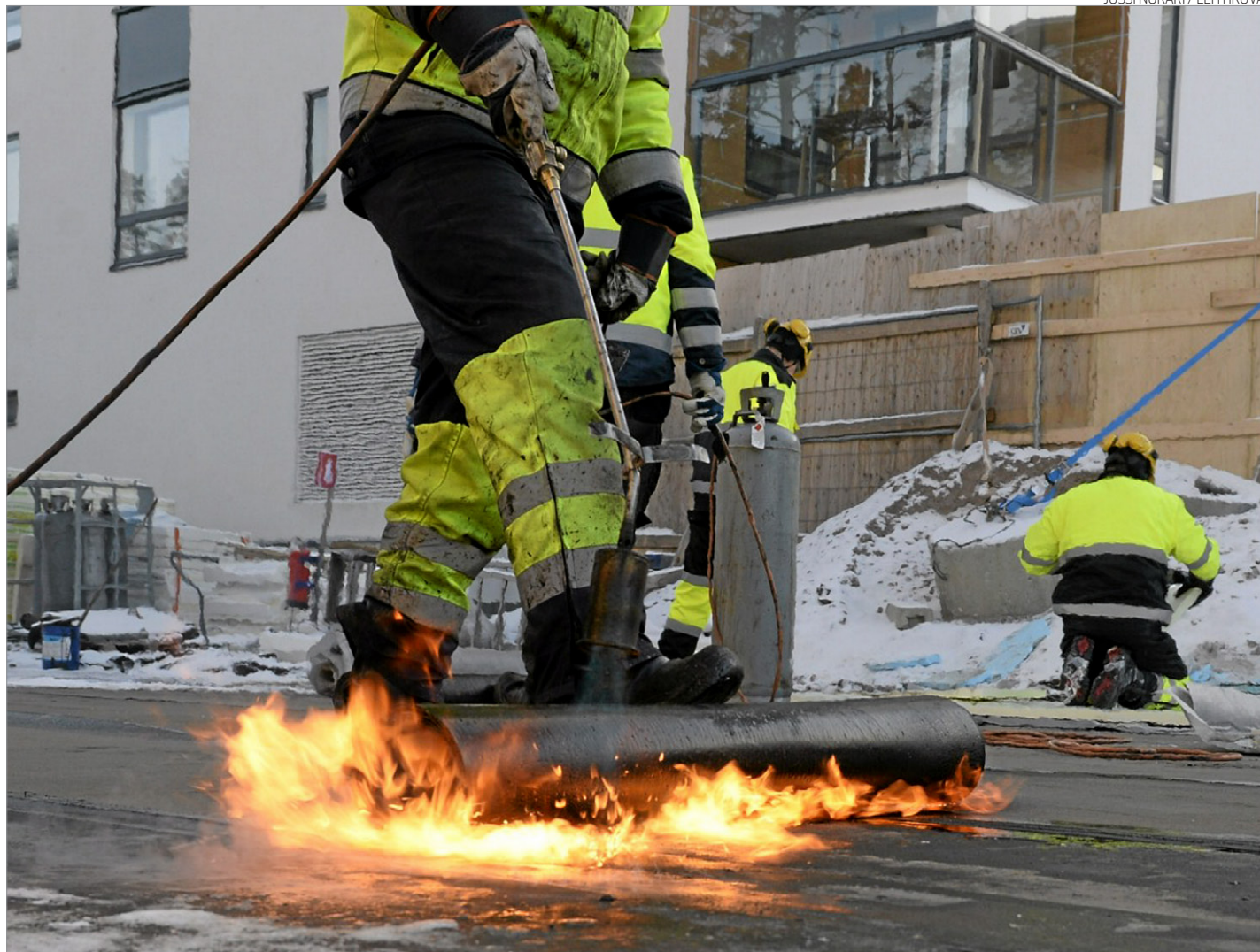
Rakennushankkeiden kilpailuttamisessa ei asiantuntijoiden mukaan kiinnitetä tarpeeksi huomiota urakoitsijoiden laatuun. Autohallin kattoa eristetään asuintalon rakennustyömaalla Espoon Tapiolassa.
